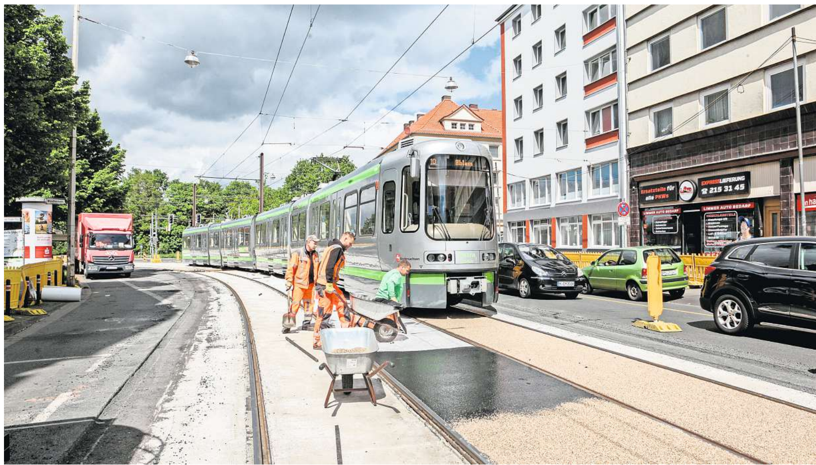
Zurzeit bessern Bauarbeiter noch Schäden an den vorhandenen Stadtbahnschienen aus – die umfangreichen Leitungsarbeiten für den Bau des Hochbahnsteigs Ungerstraße folgen dann am 7. Juni. FOTO: KATRIN KUTTER
